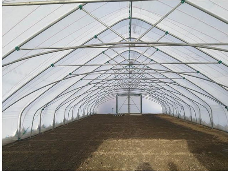
Tunel Solo - zamknięty od wewnątrz
